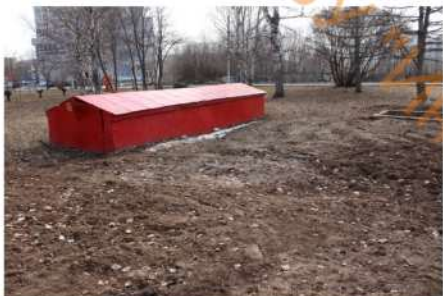
Эвакуац. выход из подземного гаража
