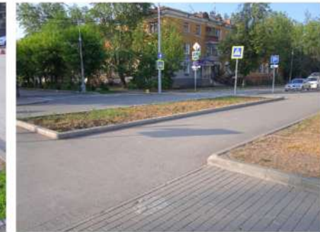
Состояние газона. Отсутствие должного ухода за газоном. Унылый вид также придаёт отсутствие цветущих кустарников или цветочно-травянистых композиций
