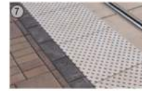
Бетонная плитка 150x150мм, толщиной 60мм
